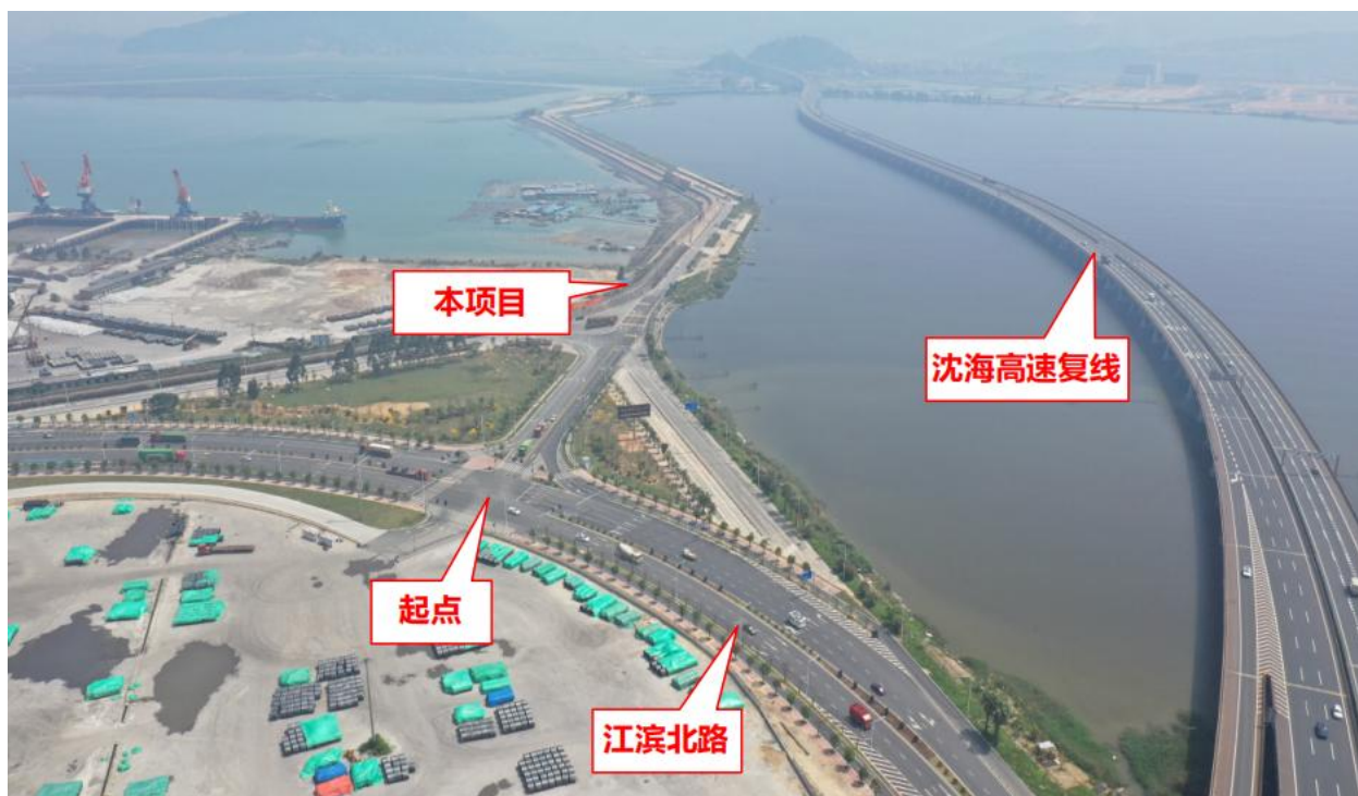
图 2.2-2 项目起点航拍图
