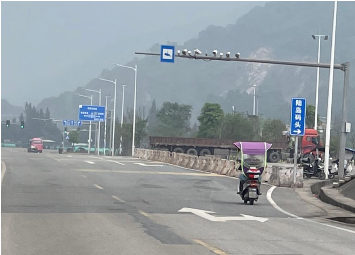
本项目施工场地布置位置现场照片
