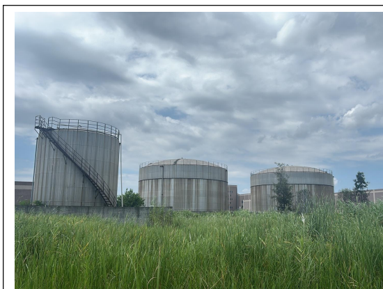
乙二醇储罐区
