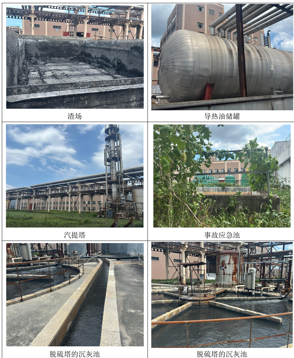
图 3.1-2 现有工程现状照片
