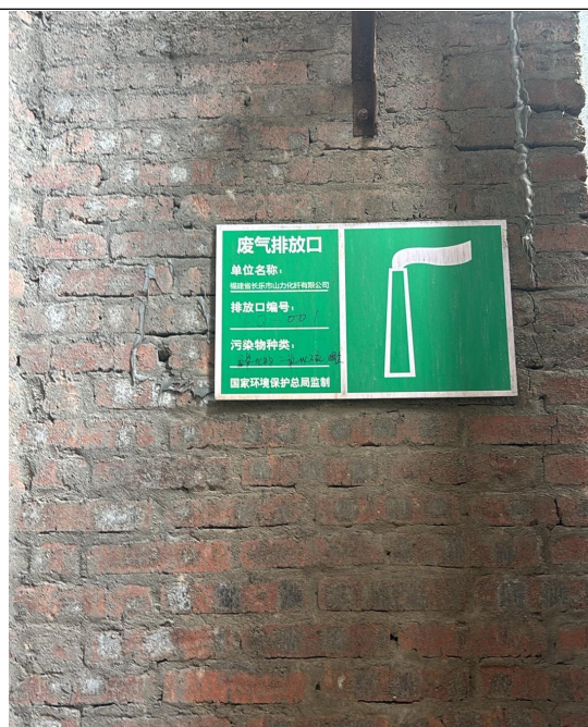
锅炉废气排放口
