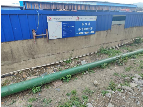
事故池及管道
