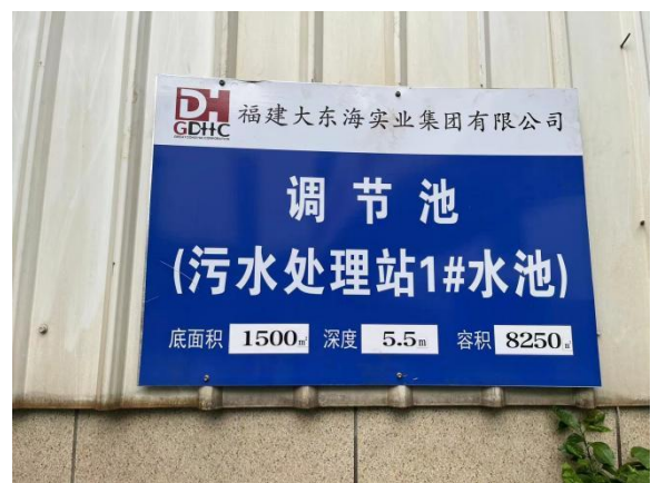
调节池（污水处理站 1#水池）
