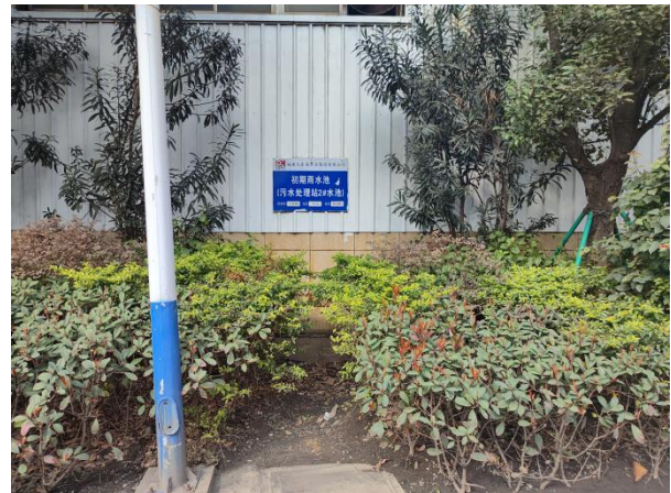
初期雨水池（污水处理站 2#水池 6600m 3 ）
