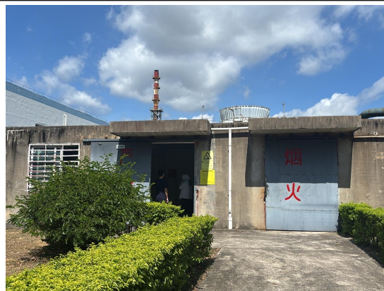
危废贮存场所
