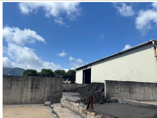
蒸汽锅炉煤渣棚
