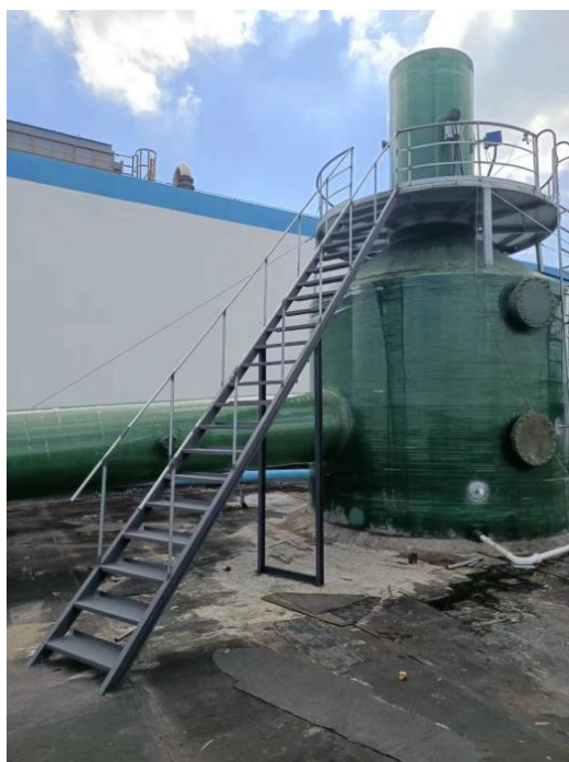
二期纺丝废气排气筒
