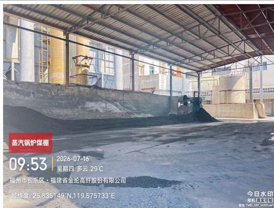
蒸汽锅炉煤棚
