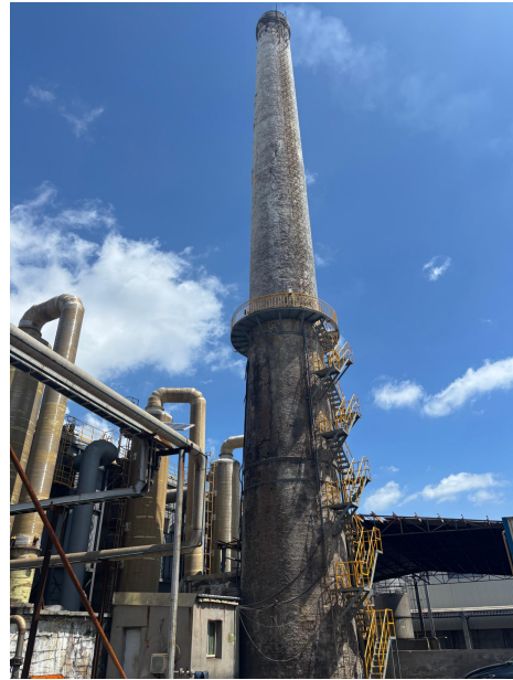
锅炉废气排气筒
