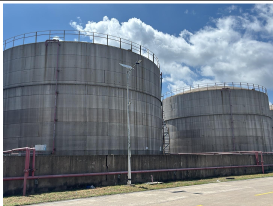
乙二醇储罐区
